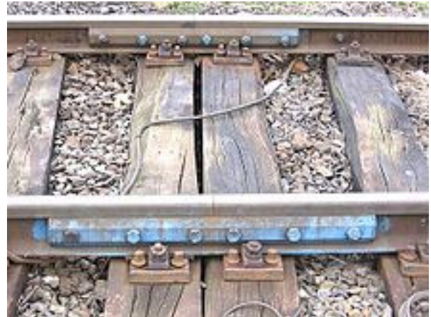
Un joint de rails éclissé
