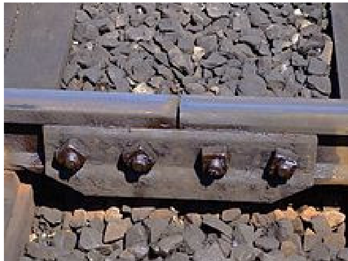
Un joint de rails éclissé
