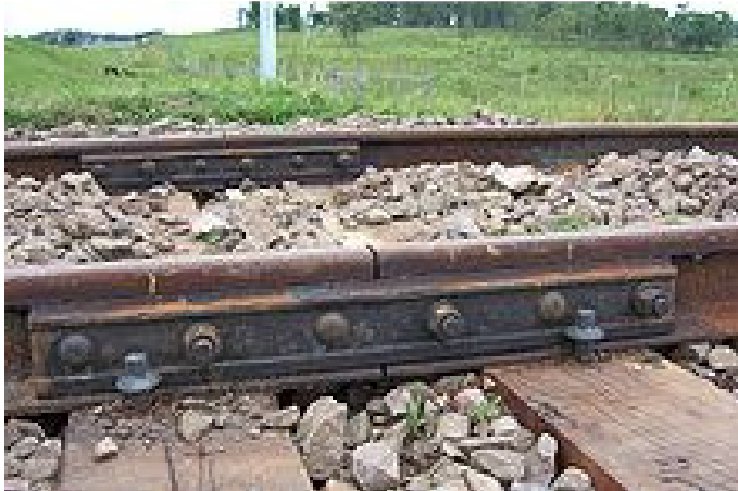
Un joint de rails éclissé
