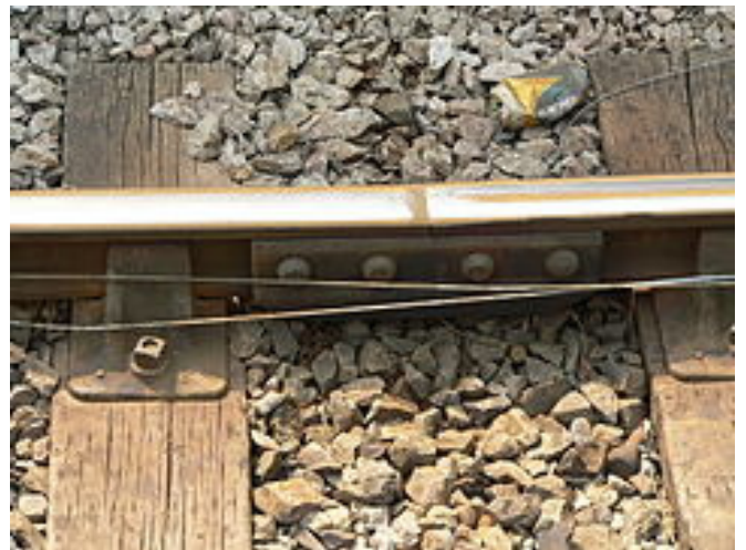
Rails décalés en hauteur
